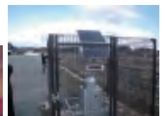
海岸に設置された線量計
