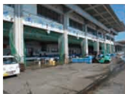
津波は一階部分がほぼ水没する高さまで押し寄せた(久慈市宮魚市場)
