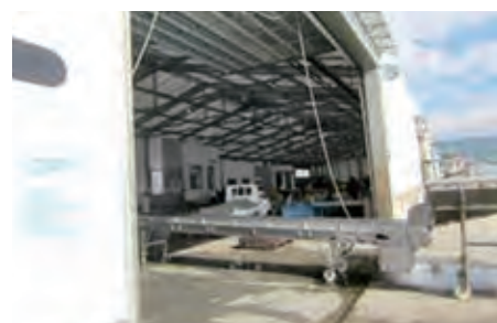
鳥などの侵入を防ぐためのシャッターが付いた建屋
