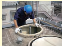
簡易専用水道検査 (1979年~)
